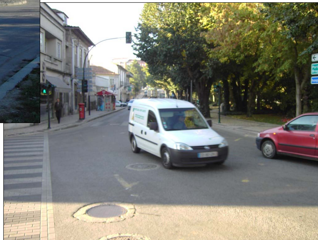
Figura 31. Exemplo de ponto crítico da rede viária urbana
