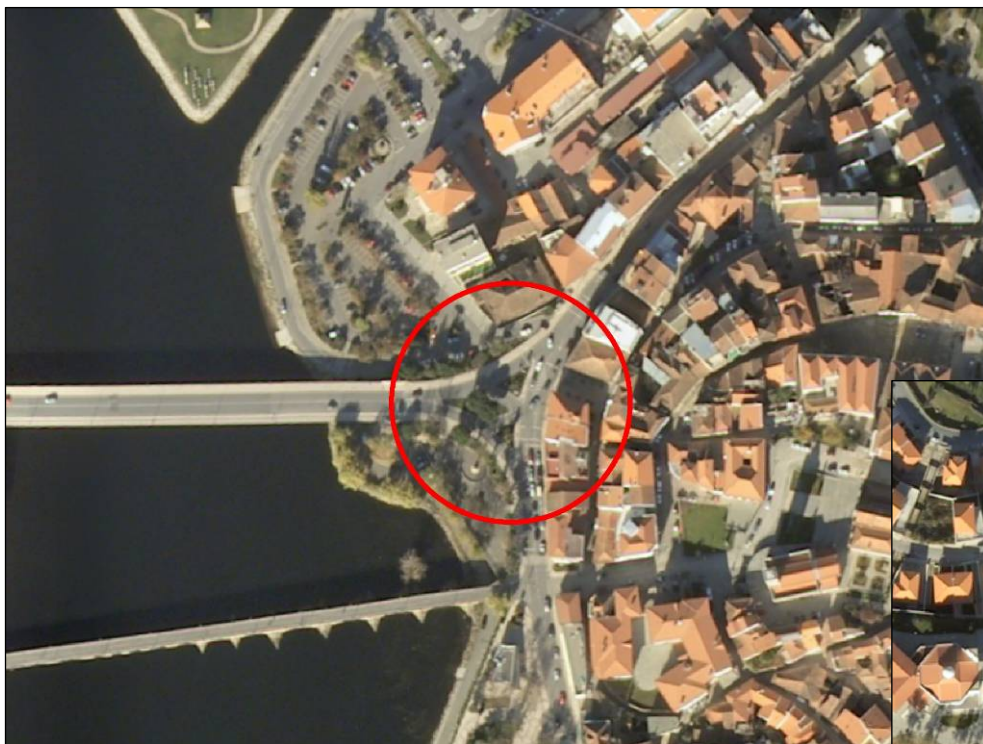
Figura 32. Exemplo de ponto crítico da rede viária urbana
