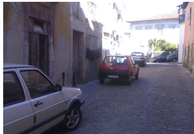
Figura 38. Ocupação ilegal do passeio
