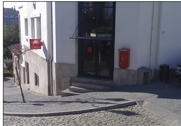
Figura 43. Serviço público inacessível a PMR
