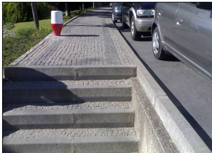
Figura 42. Obstáculo à circulação de PMR
