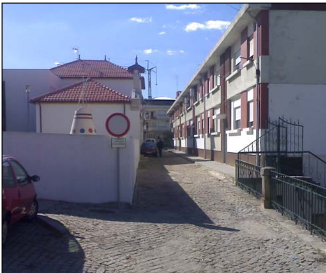
Figura 40 - Rua de acesso limitado a cargas e descargas
