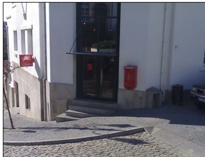
Figura 43 – Serviço público inacessível a PMR
