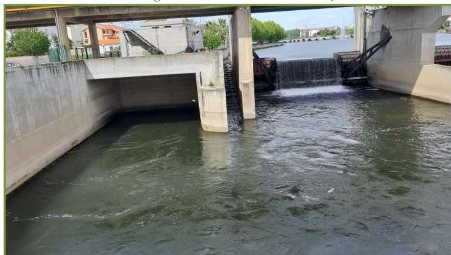
**Figura 11 – Vista da escada destinada à passagem dos peixes**
