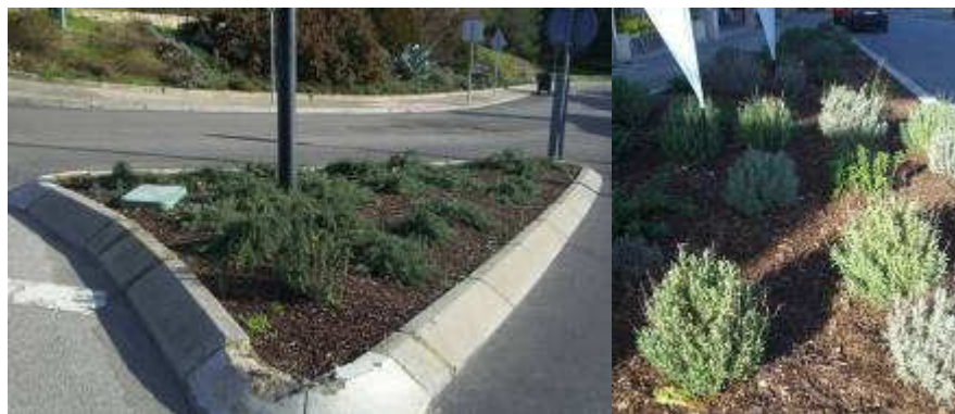
Figura - Obras de construção e melhoramento de dois pequenos espaços verdes recorrendo a técnicas de “Xerojardinagem”.
