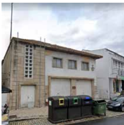
Centro Municipal de Proteção Civil
