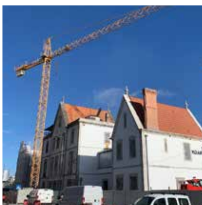
Reabilitação da Estação de Caminho de Ferro de Mirandela
