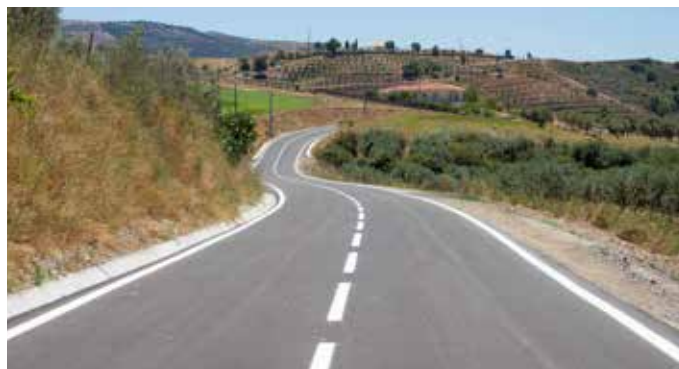
Conclusão das obras da estrada entre a aldeia de Vale Pereiro e Carvalhais.
