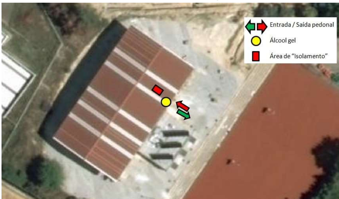
Figura 14 – Pavilhão Desportivo da Escola Secundária de Mirandela, CMM. Fonte: Ortofotomapas, DGT, 2018; CMM, 2020.
