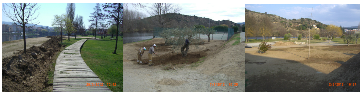
Figura 1 - Obras de beneficiação e melhoramento do espaço verde Parque José Gama.
