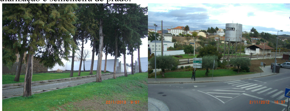
Figura 2 - Obras de beneficiação e melhoramento do espaço verde anexo ao posto de turismo e acesso ao cemitério.
