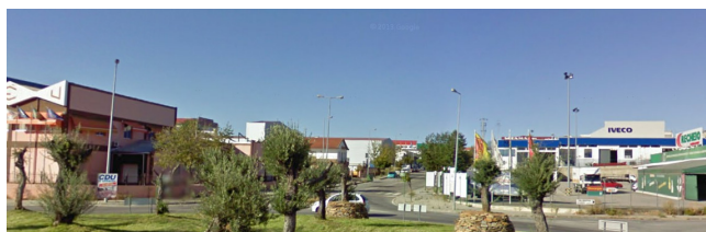
Imagem 2 – Imagem da Zona Industrial de Mirandela
