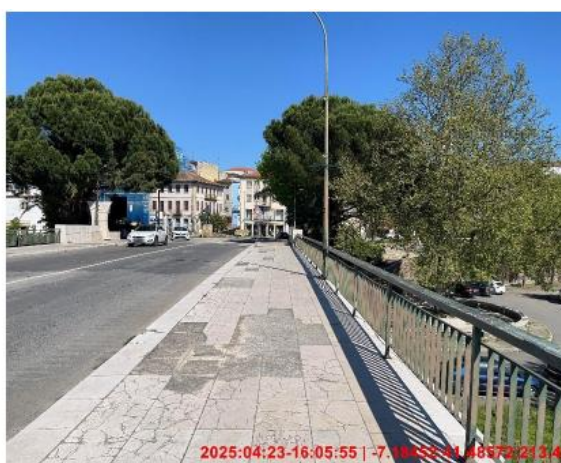
Figura 6. Vista geral do passeio de jusante dos 2 vãos a nascente.
