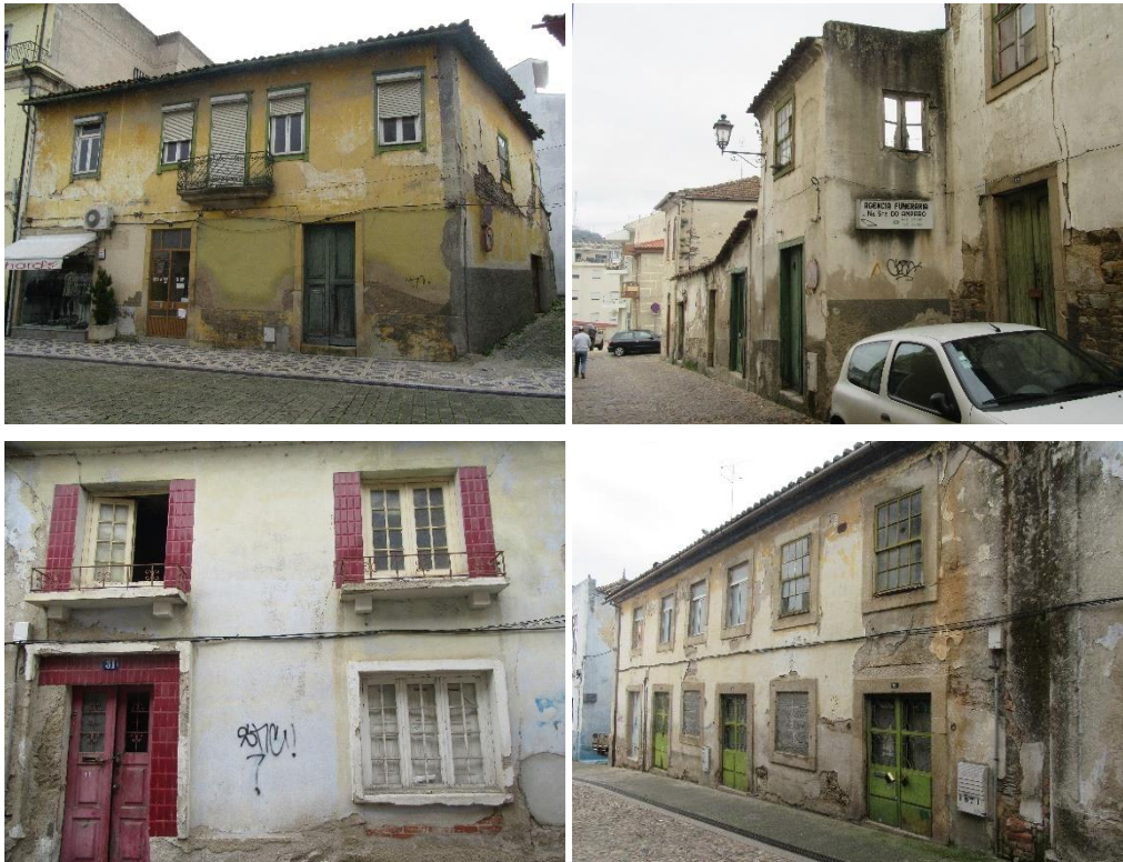
Figura 46. Exemplos de edificado em mau estado de conservação/ruína.
