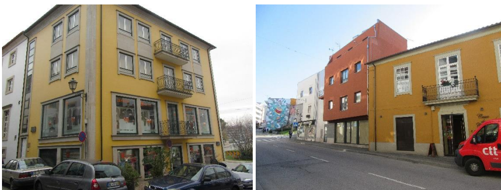
Figura 45. Exemplos de edificado em bom estado de conservação.
