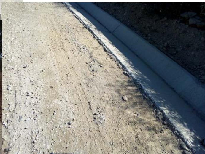
Pavimentação da EM 582-2, de Acesso ao Navalho
