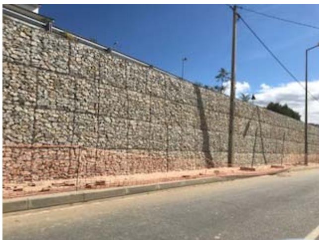
Construção de muros de suporte em gabião para criação de via pedonal
