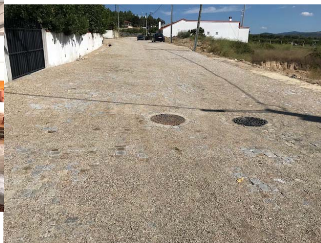
Pavimentação de arruamentos vários em Torre de Dona Chama
